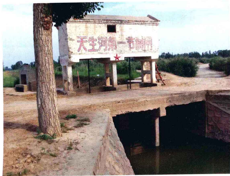
天生河第一节水闸(摄于2008年7月24日)
