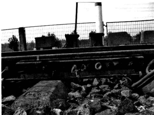
图 1—13 胶接绝缘接头
