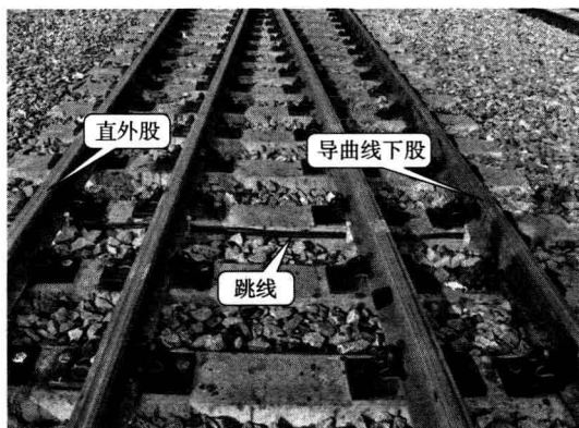
图 1—11 轨道电路跳线
