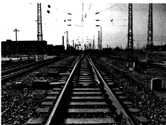
图 1—4 混凝土枕 60 km/g 钢轨 18 号 单开道岔 (CZ531PS)
