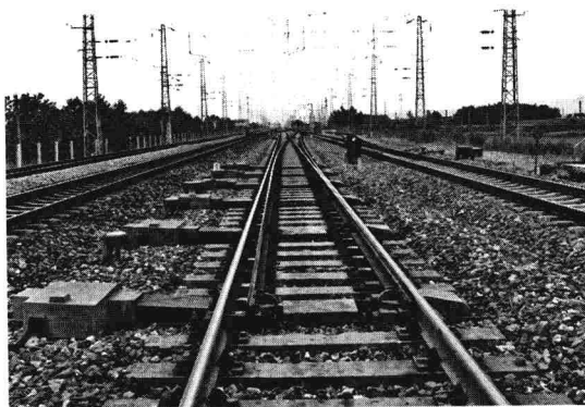
图 1—6 混凝土枕 60 km/g 钢轨 30 号单开道岔(专线 4261)
