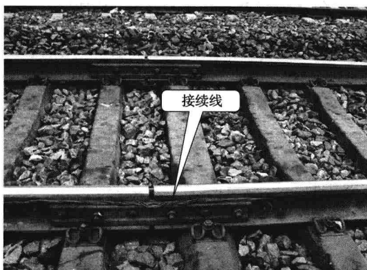
图 1—9 轨端接续线
