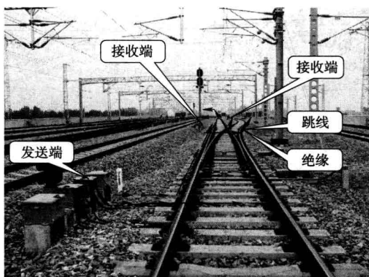
图 1—8 道岔轨道电路
