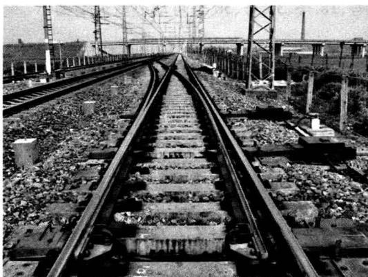
图 1—3 混凝土枕 60 km/g 钢轨 12 号 I 型 单开道岔 (CZ559A)
