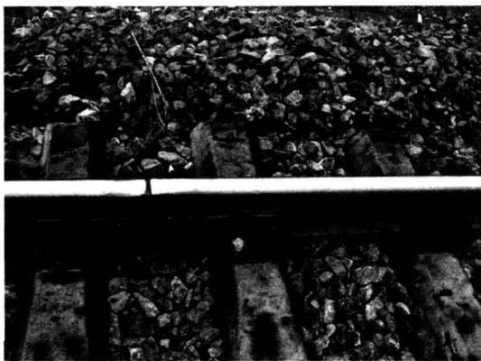
图 1—14 本克拉绝缘接头
