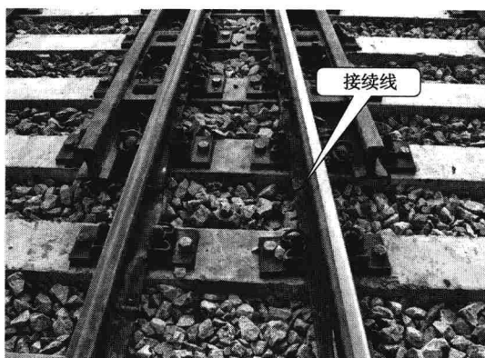
图 1—10 无缝道岔跟端接续线
