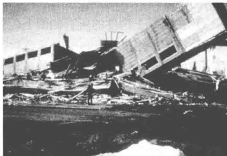
图 1.11 六层预应力升板结构, 由两个楼梯井筒承担地震水平力。地震时井筒折断, 并向一侧倒塌, 楼板重叠在一起坍塌
