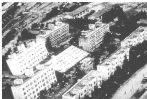
图 1.8 地基液化导致楼房倾斜倒塌
