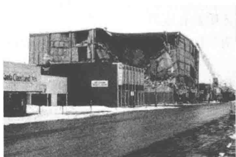
图 1.10 五层钢筋混凝土结构的 Penney 公司大楼, 因剪力墙布置偏心产生扭转破坏, 外墙板坠落, 部分梁柱折断, 楼层倒塌
