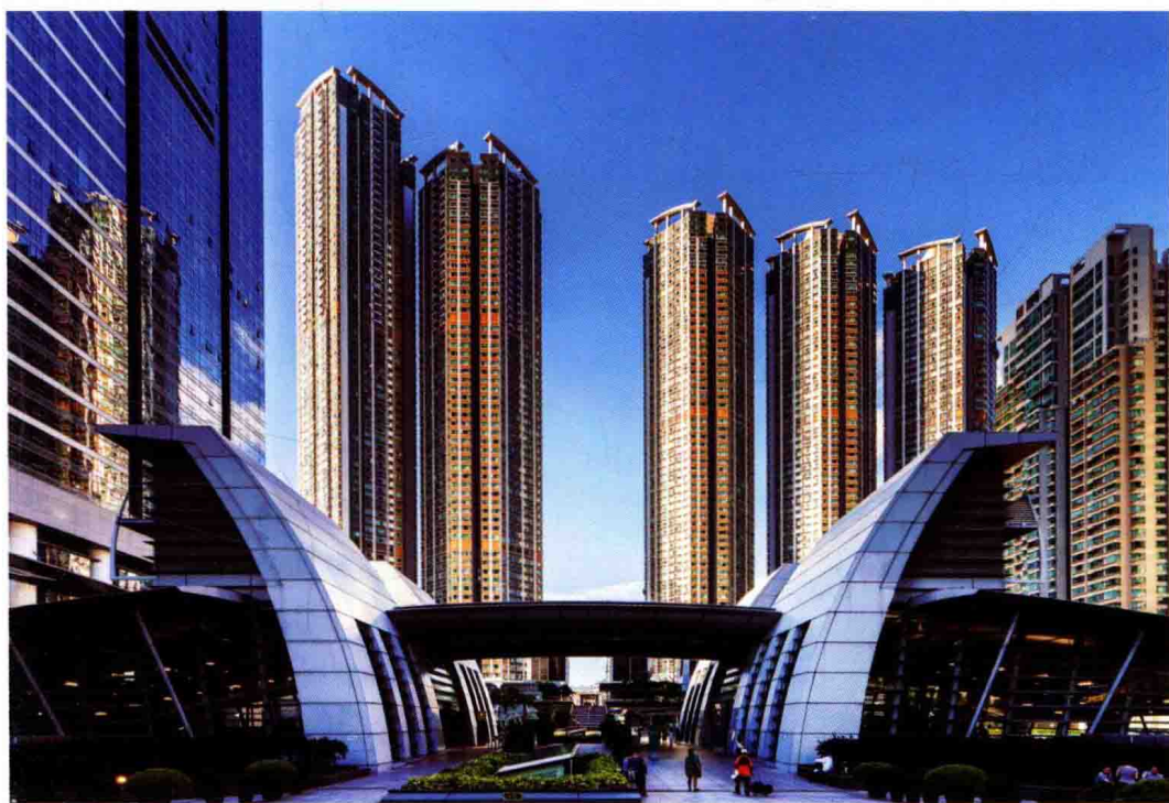
香港九龙车站扩建工程, 由特里·法列尔领衔于 1998 年至 2010 年设计。
