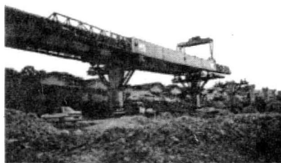
图 1.4 马来西亚吉隆坡轻轨施工
