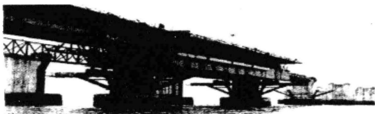
图 1.12 移动模架海上施工
