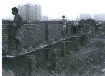
图 1-2 现场临时工棚单层砖房
