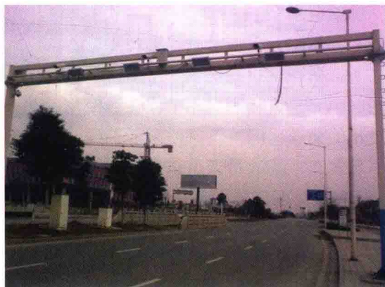
图 1-2 ETC 自由流式检测基站示意图
