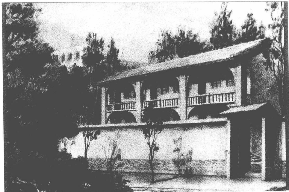
中国劳动组合书记部武汉分部旧址——武昌黄土坡下街27号
