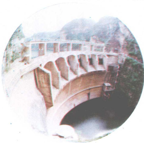
1990 年完工的观音岩电站拦河大坝，坝高 82.1 米。 图为大坝施工时渡汛一景。
