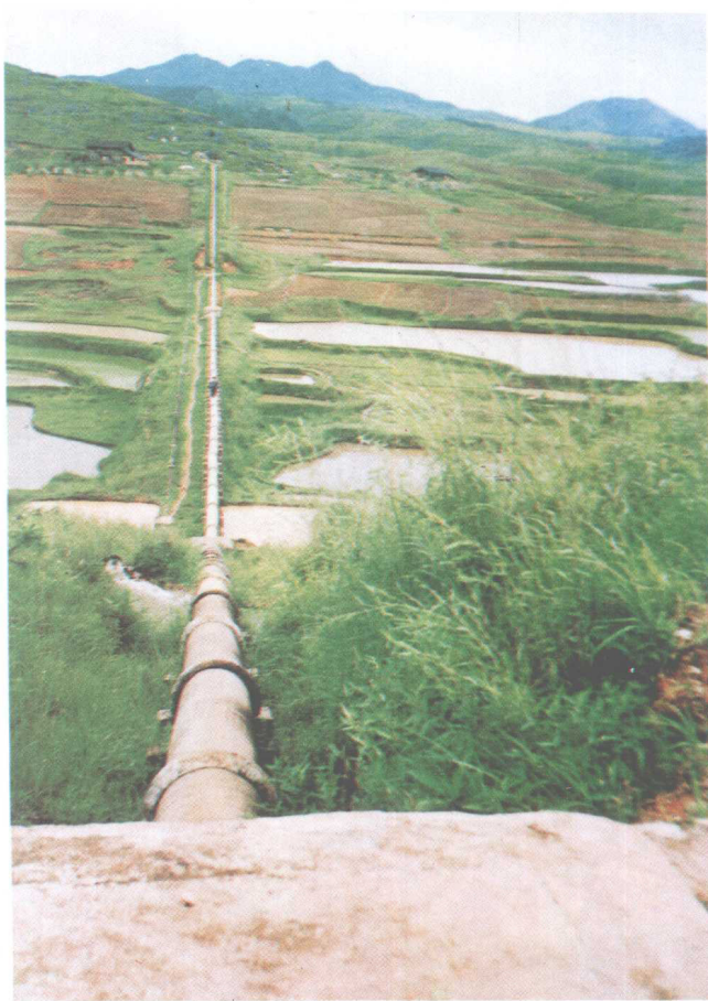
黎平墨门山水库东干渠曼坡倒虹管
