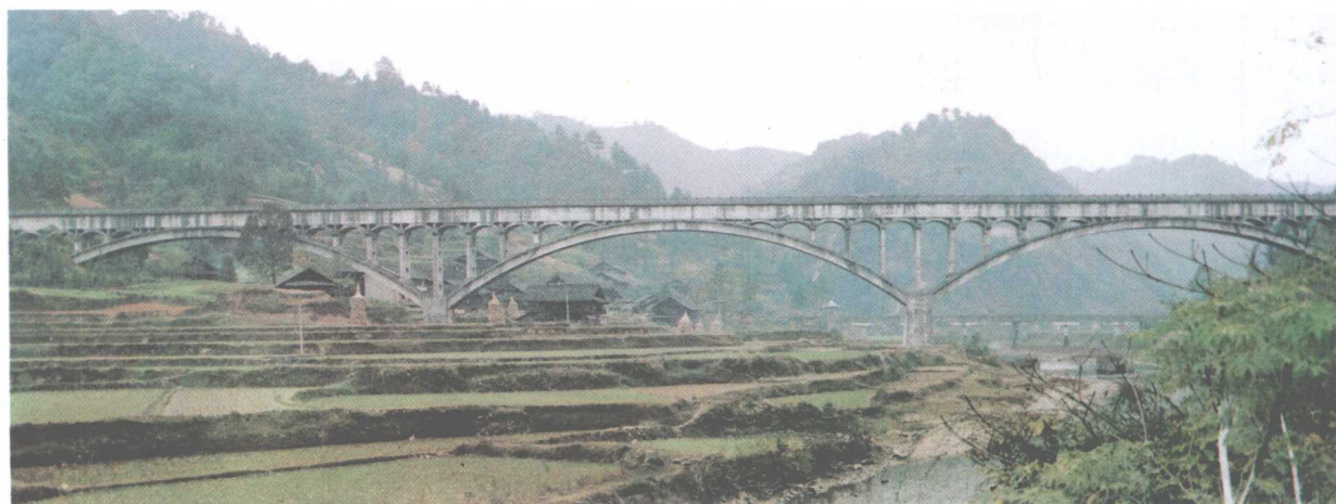
天柱鱼塘工程平福一号渡槽
