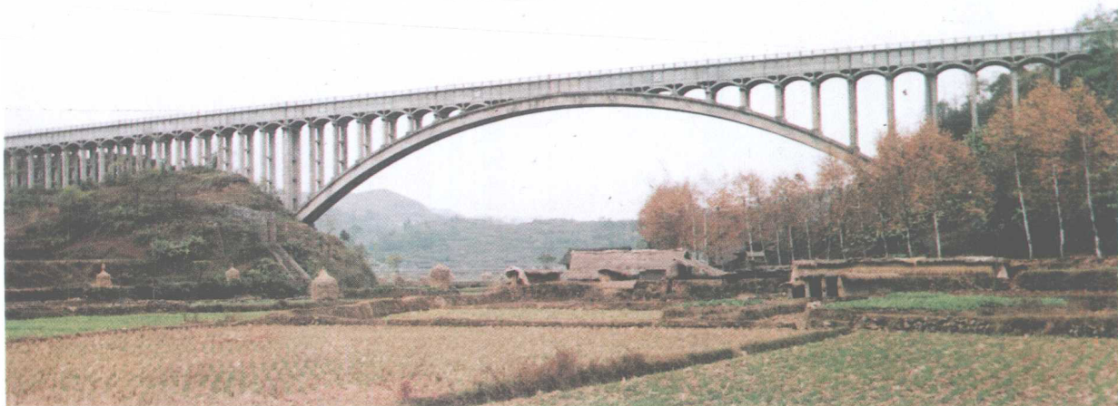
天柱鱼塘工程水口渡槽
