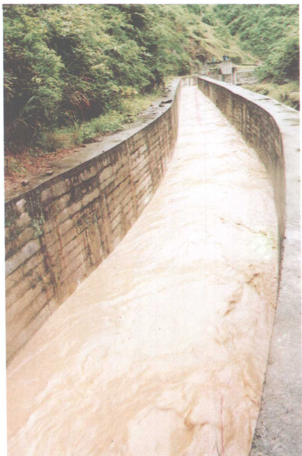
天柱鱼塘工程主干渠一段
