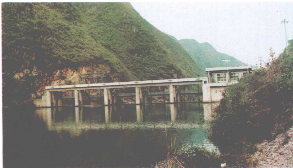
镇远东峡电站
