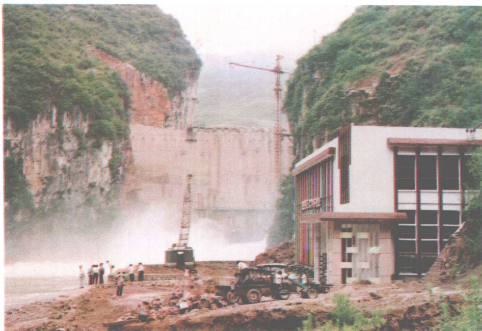
1990 年完工的观音岩电站拦河大坝，坝高 82.1 米。 图为大坝施工时渡汛一景。
