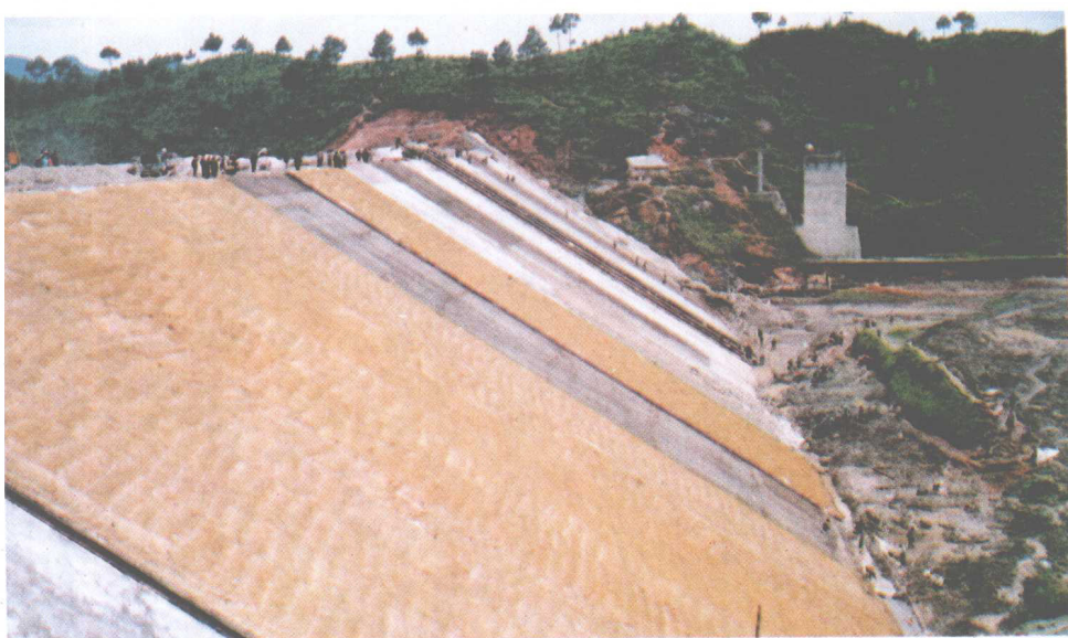
黄平两岔河水库大坝，高 43 米，坝顶长 300 米，是贵州省首例钢筋混凝土面板碾压砂砾石坝。图为正在施工中的钢筋混凝土面板养护一景。
