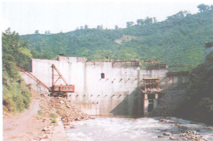
施工中的黎平双江电站大坝
