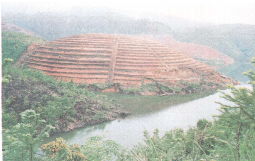
锦屏水冲溪水库水土保持坡改梯工程一角
