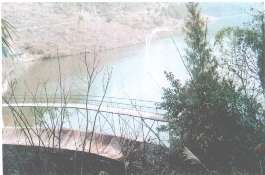
台江濫塘水库
