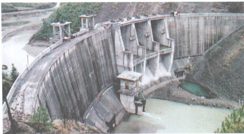
天柱鱼塘水库大坝
