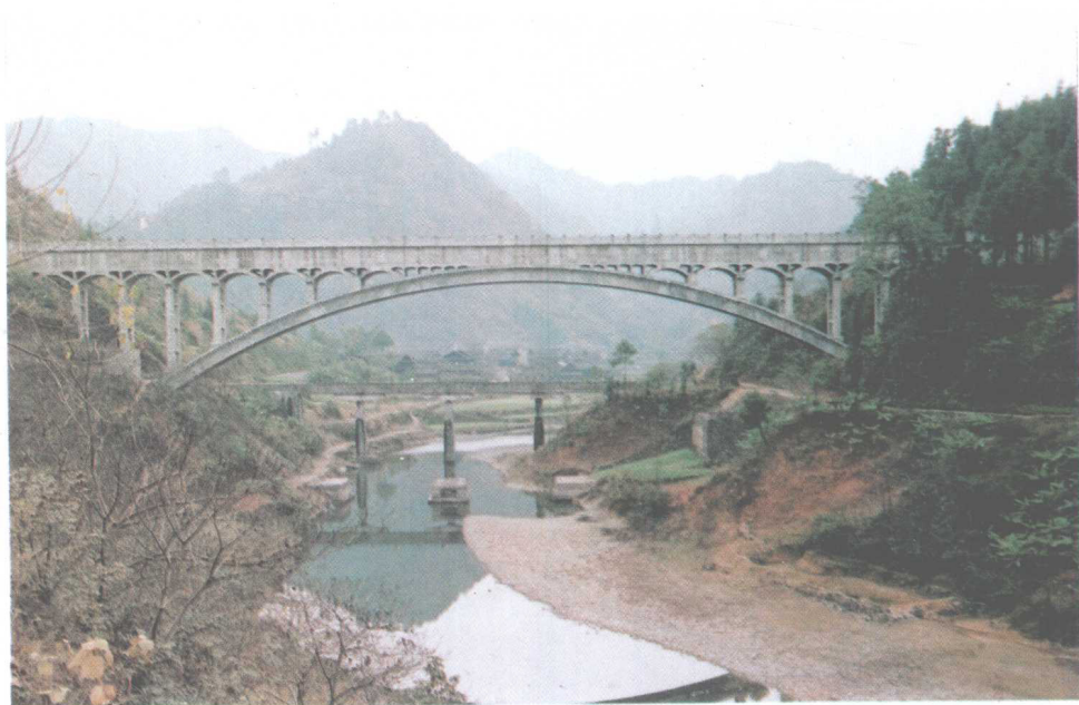
天柱鱼塘工程平福二号渡槽
