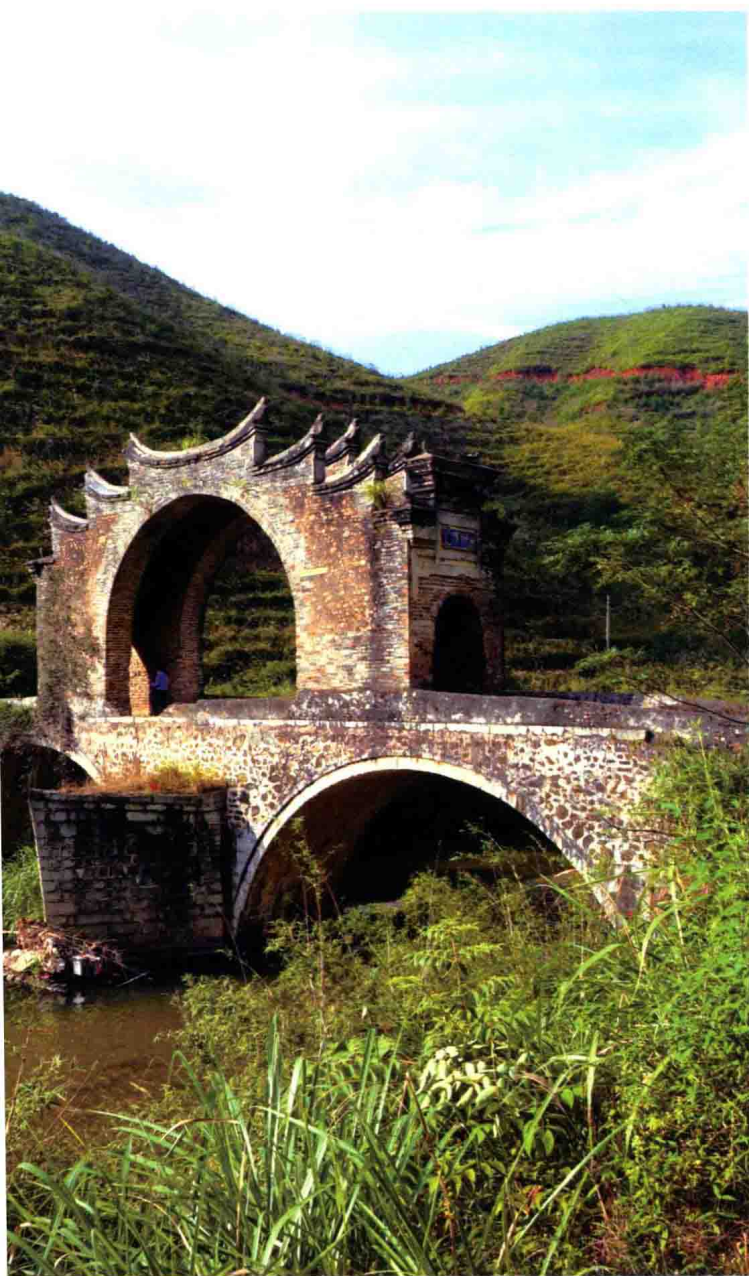
赣南深山中的客家廊桥（江西龙南太平桥）
