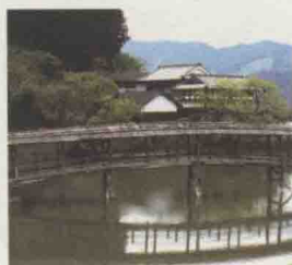
位于内子的屋顶桥
