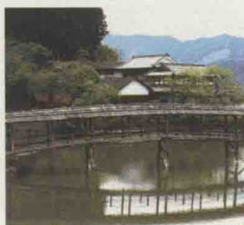
位于内子的屋顶桥
