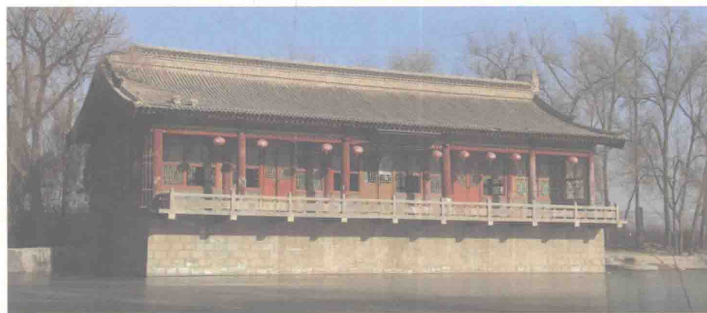
甘肃武威凉州府署大堂
