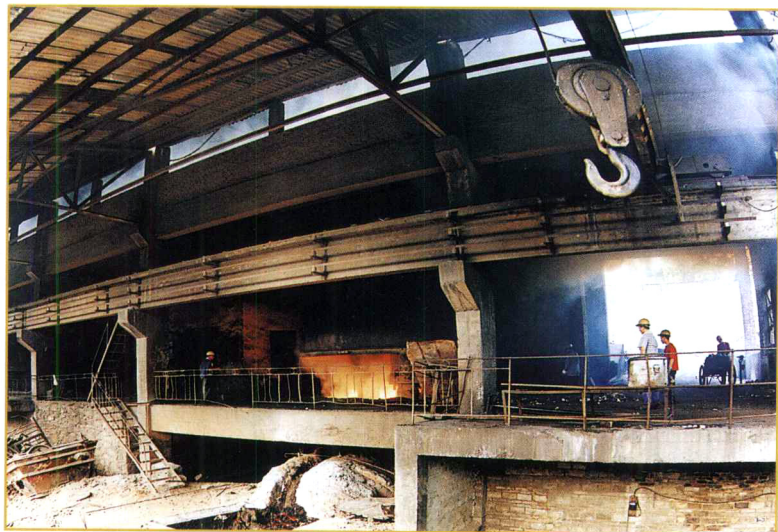
遵义县南白铁合金厂生产车间
