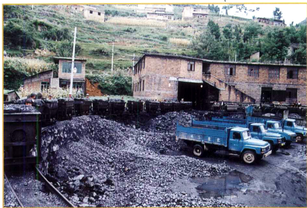
习水县庙坪煤矿（6万吨）工业广场
