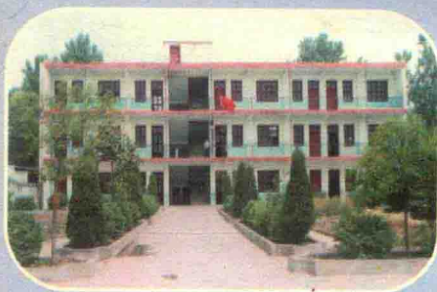
▶ 桃园村小学教学楼
