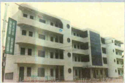
◀ 九八年新建的浙河镇二中教学楼
