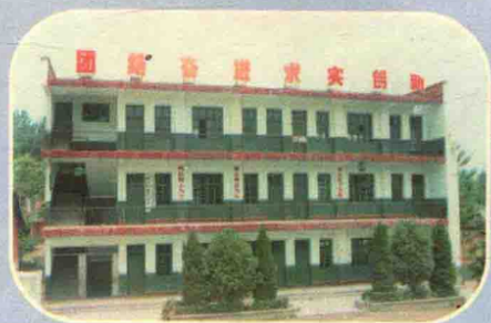
◀ 罗井村小学教学楼
