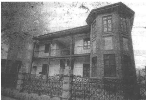
中统起家之地“正元实业社”。这里就是南京中山东路中央饭店东楼，现已被拆。
