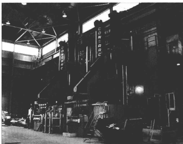
图 2-5 10t 真空自耗炉 8 台/等离子炉 2 台
