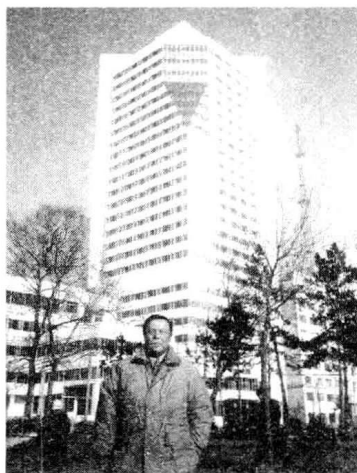
图1-3 齐鲁大厦纠倾扶正后照片
