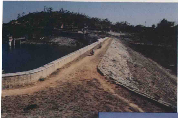
菱溪水库放水塔
