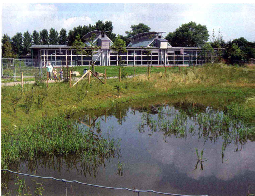
图 1-2-13 雨水收集池及风雨操场
