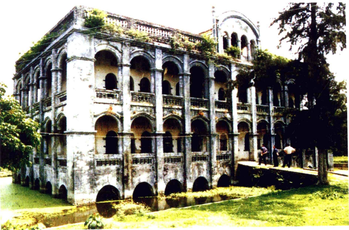
博白县太平坡客家水楼。
