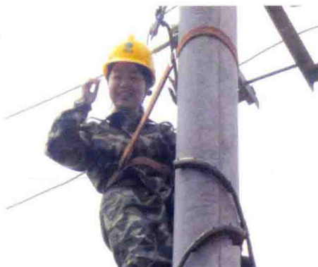
黄集供电公司职工正在抢修线路
