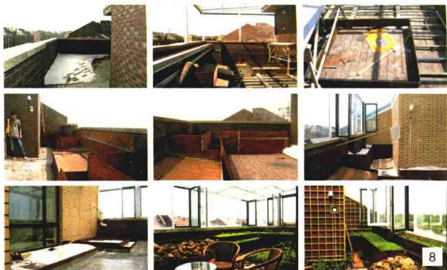
图8 阳台墙施工过程图
