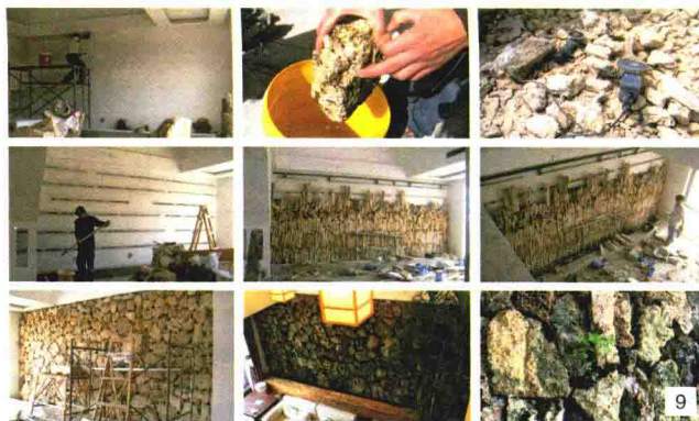
图9 生态墙施工过程图
