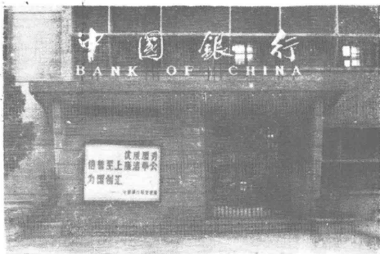
县中国银行办公楼
