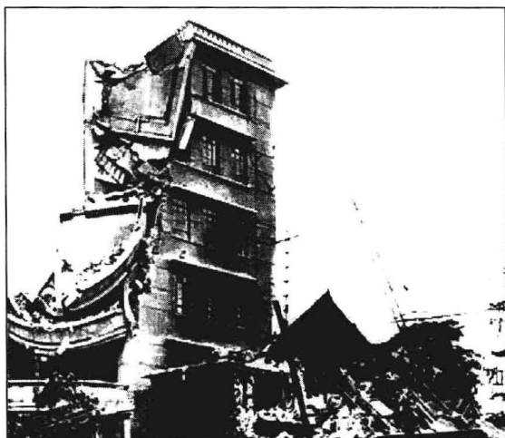
图0-2 唐山地震倒塌的开滦煤矿医院
