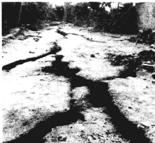
图0-1 唐山地震的地裂缝
