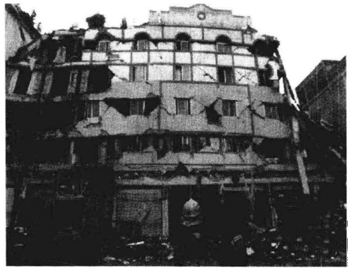
图 0-14 汶川震后的底框砖混结构房屋
