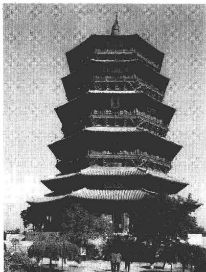
图 0-6 山西应县木塔
