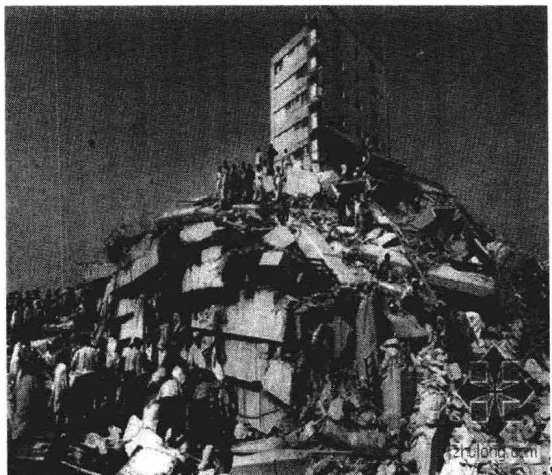
图 0-10 汶川地震中倒塌的房屋
