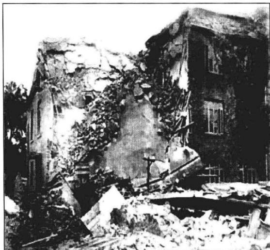
图 0-3 唐山地震倒塌的砖混结构办公楼
