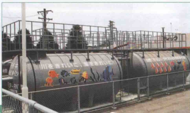
废水合并 处理净化槽
