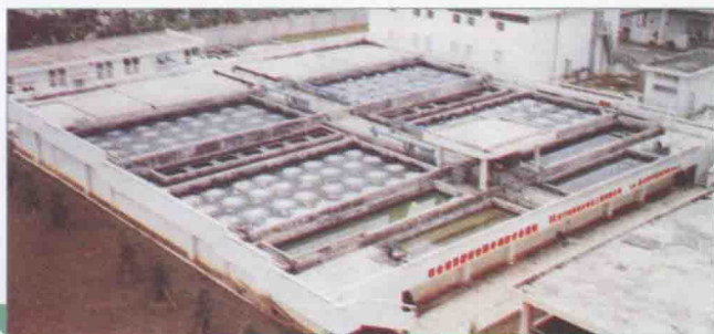
污水处 理站全貌
