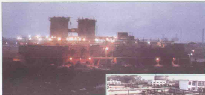
河南省 莲花味精集团 污水处理厂
