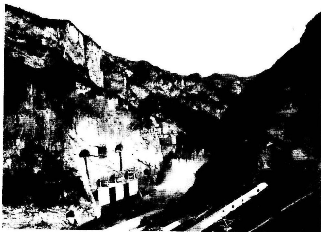
◀ 2004 年，正在施工建设中的“西电东送”重点工程索风管水力发电站，总装机容量达 600 兆瓦
