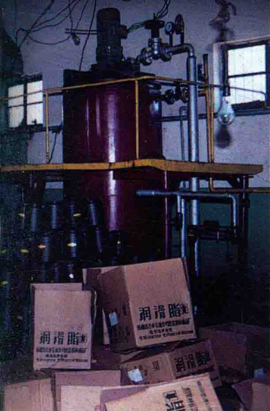
润滑油厂(昌吉州石油运输公司)
