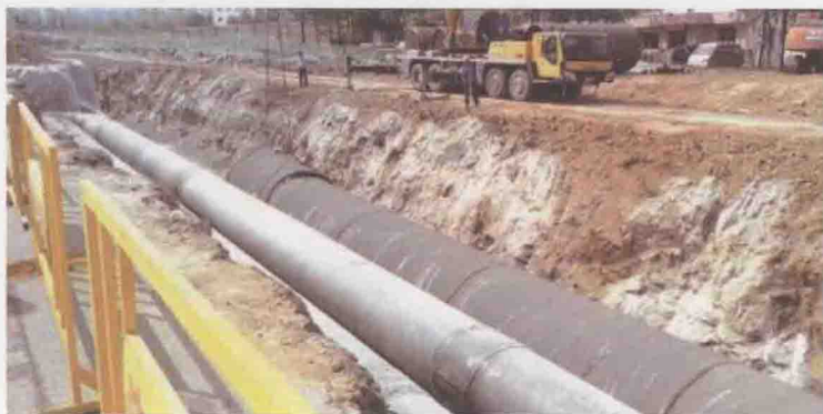
图 1-2-1 地下给排水管网
