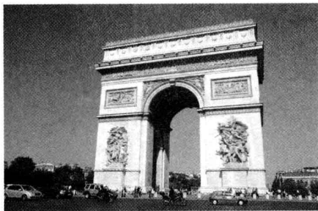
图 1-8a 凯旋门 (Arc de Triomphe Etoile), 沙勒·格兰 (Chal Grin), 法国巴黎戴高乐星形广场, 1836 年
