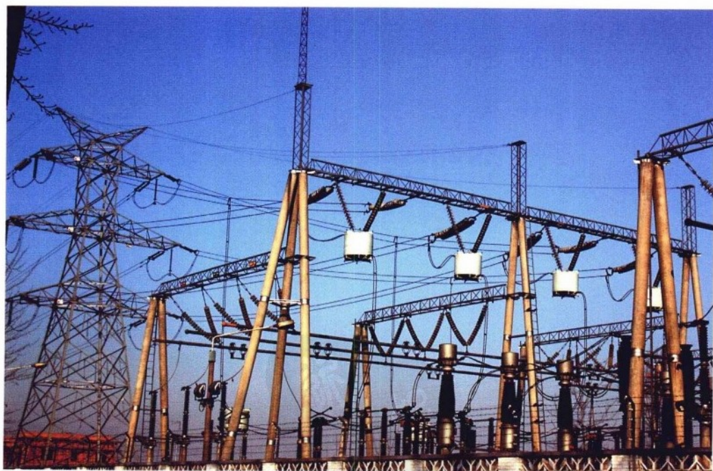
房山区韩村河镇低压电网改造工程
