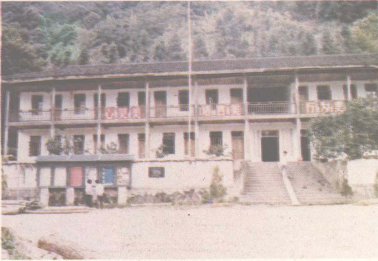
龙南县安基山综合垦殖场
