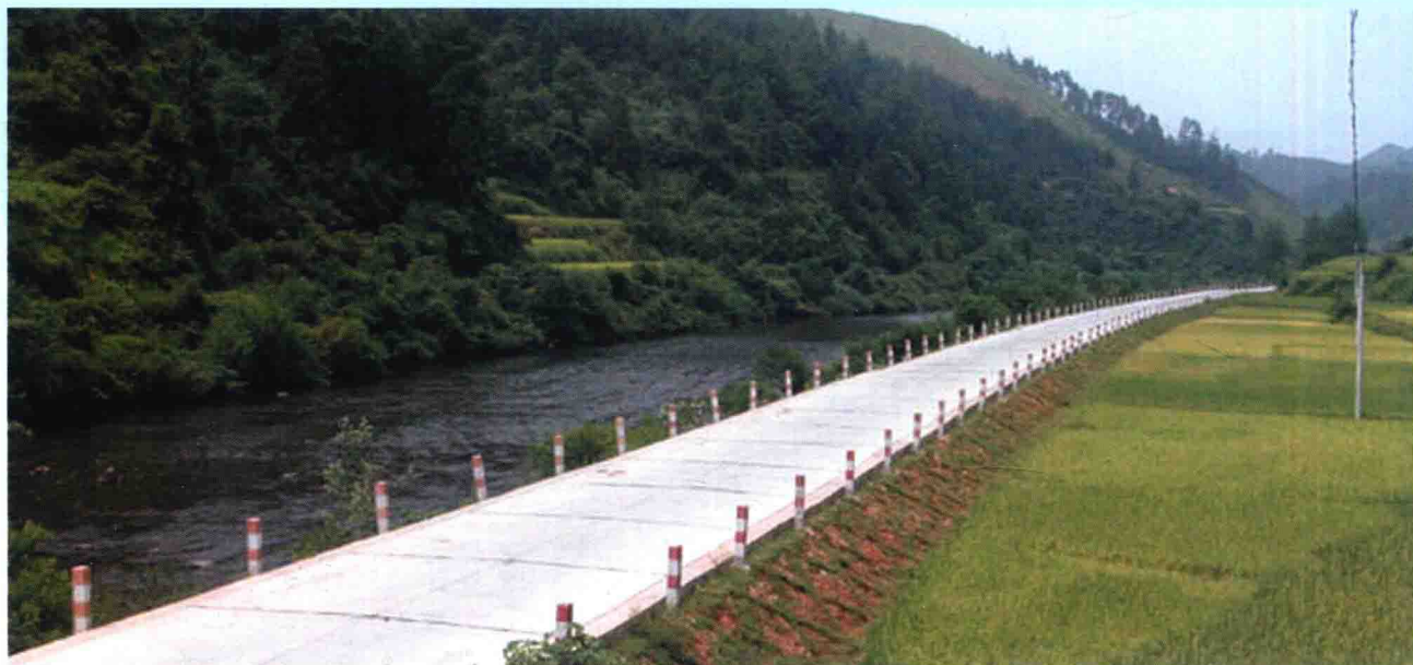
绥宁新改造的通村公路
