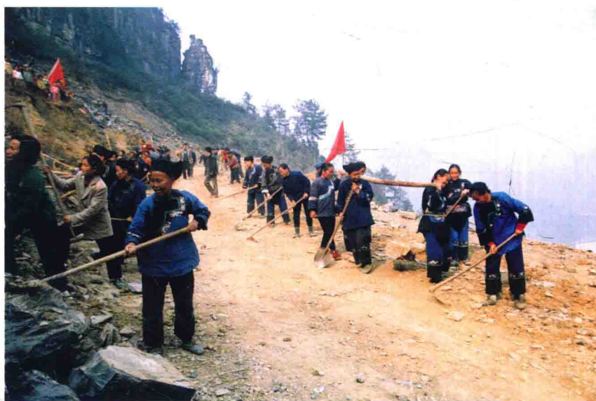
自力更生修公路（湘西）
