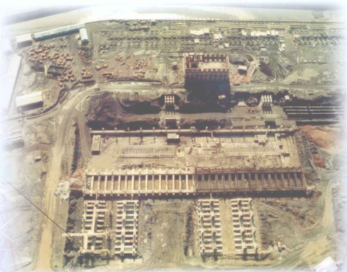
▲ 一九九一年,盘县发电厂1号机组开挖,负零米建筑施工。
