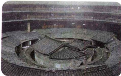
闽、粤三省的大山中定居下来。客家人有着聚族而居的远古习俗和以血缘为纽带的社会关系，他们在宗族感召力的影响下，共同生活，共同劳作。福建漳州、南靖、龙岩、永定和江西赣南一带的大量客家土楼，是民宅中的奇特建筑。建造土楼基本就地取材，用石、竹、木、土等混合夯筑，施工方便，造价低廉。主承重的墙体用生土夯实，墙中布满竹板式木条作为筋骨，使土楼更加坚固。当地土楼最早的态式是方形，有宫殿式、府第式，形态不一。外观是高大的土墙，无窗洞，坚实牢固，形似堡垒。屋顶形
