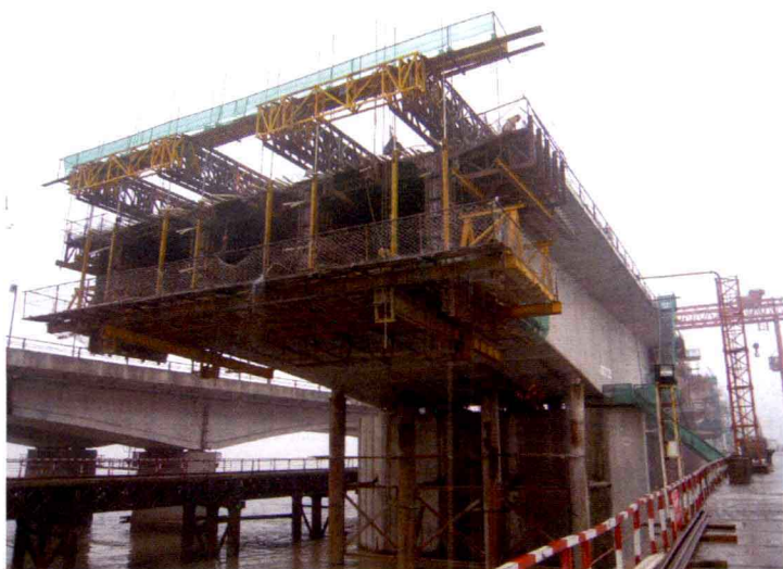
图 1—3 平行弦桁架挂篮
