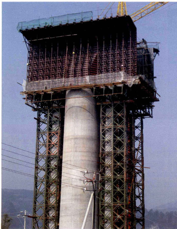
图 3.1.1—2 安装规范的 0 号块支架
