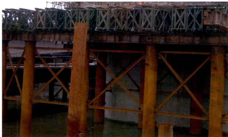
图 3.1.1—1 钢管混凝土立柱支撑系统
