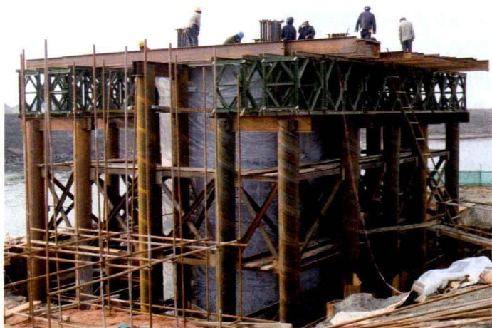
图 3.1.1—4 正在施工中的 0 号块支架
