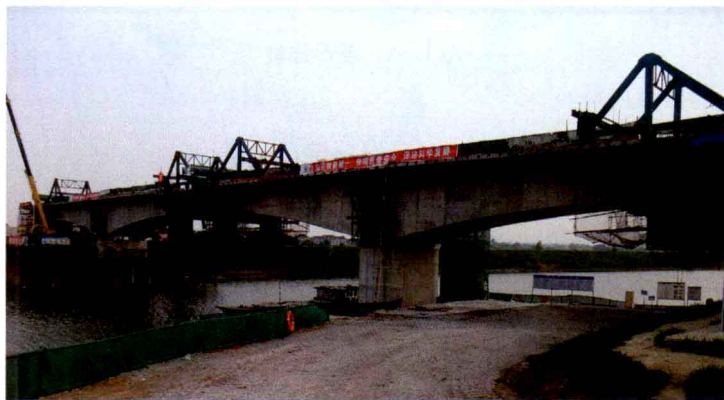
图 1—1 三角挂篮连续梁桥施工
