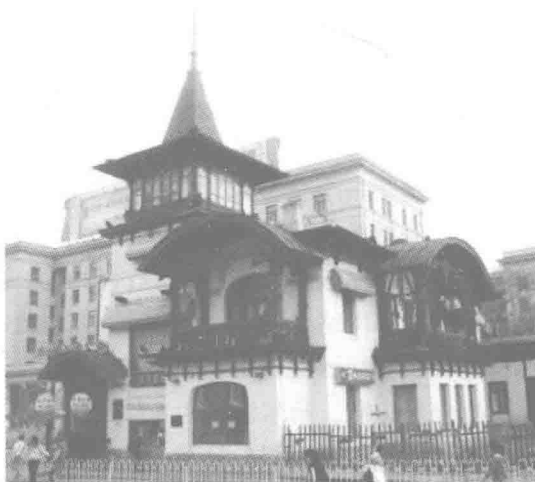
中东铁路管路局局长官邸，建于 1920 年，新艺术运动风格建筑，位于南岗区红军街 38 号
