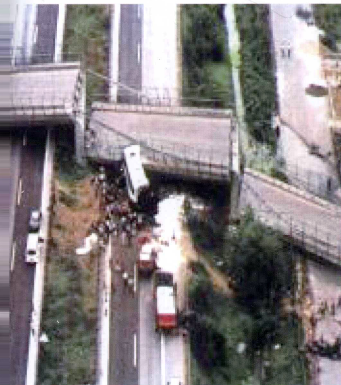
土耳其伊兹米特地震时高速公路高架桥严重破坏
