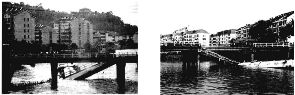
图 1-3 江苏昆山大洋桥倒塌现场照片(来自互联网)
