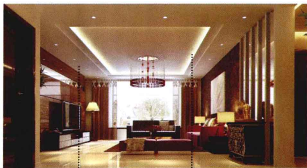
石膏板吊顶 反光灯带
