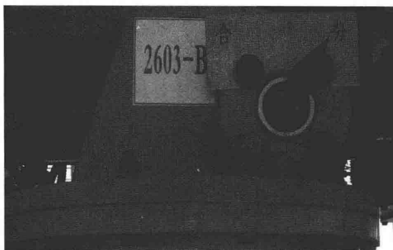
图 1-7 隔离开关机械位置显示
