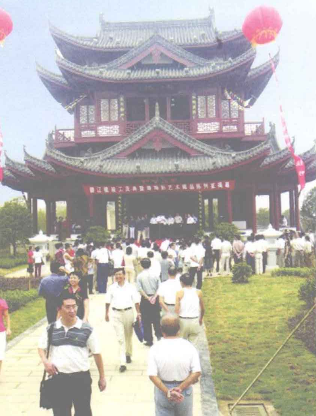
◀锁江楼重建竣工
