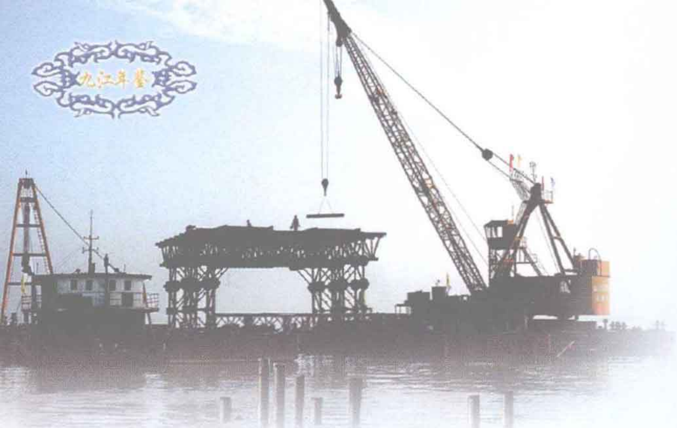
鄱阳湖特大铁路桥开工建设
