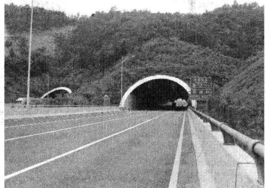
图0.1-3 深圳雅宝隧道
