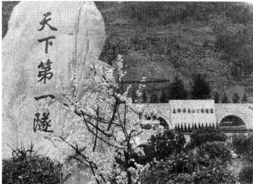
图0.1-2 秦岭终南山公路隧道
