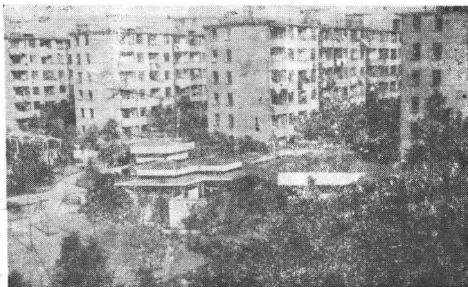
塔城路小区居委会
