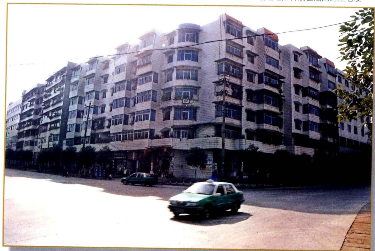
铜江经济开发区商品房住宅楼
