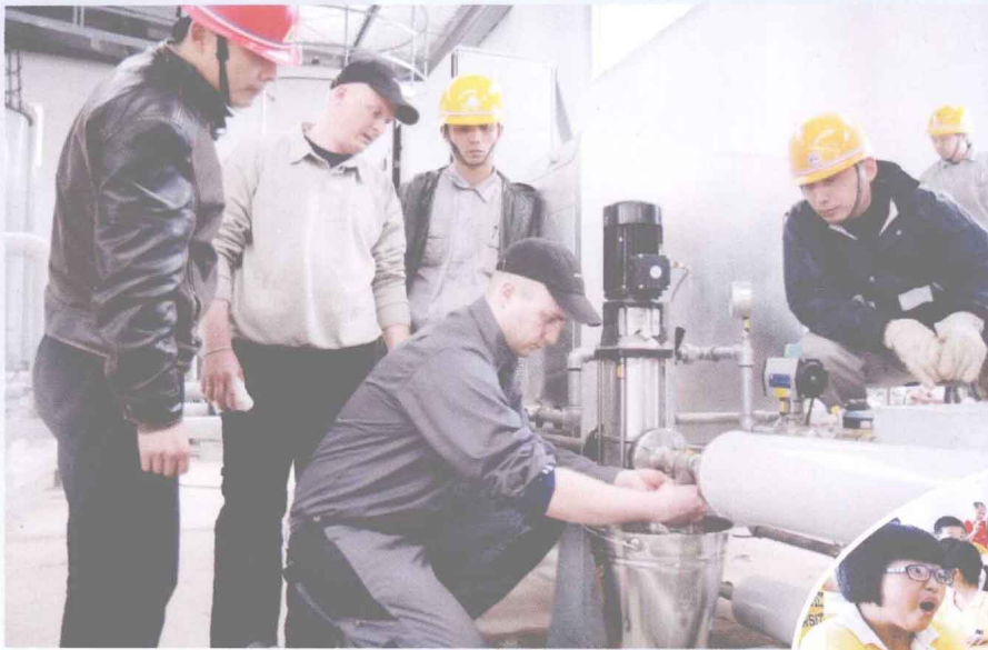
丹麦工程师调试安装进口设备。（洪显志 摄）
