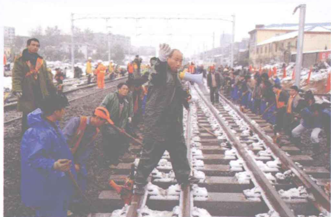
京九电气化九江段施工完工。(洪显志 摄)
