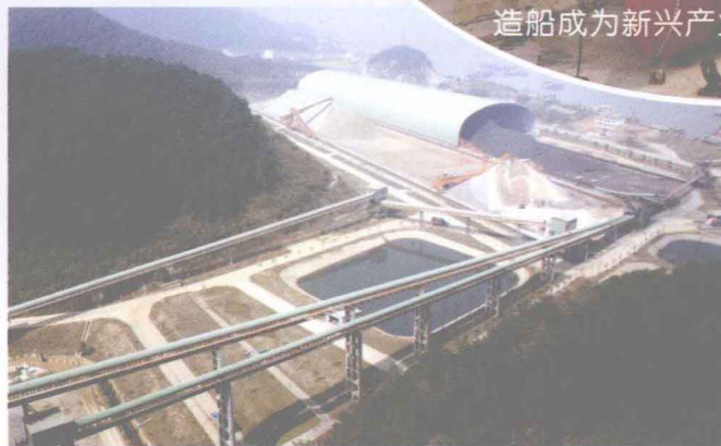
建设中的亚泥四期工程。(蔡杰 摄)
