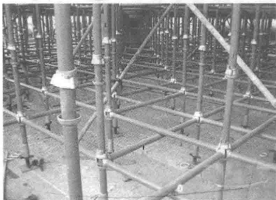
图 1-21 建筑工地脚手架
