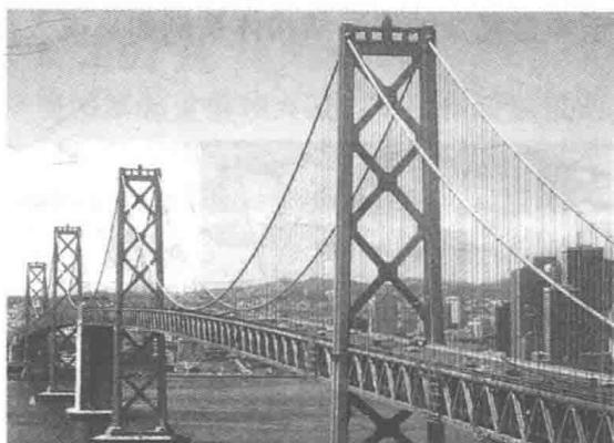
图 1-9 钢结构悬索桥
