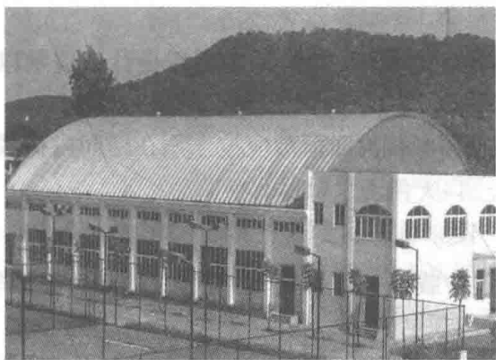
图 1-23 金属拱形波纹屋盖
