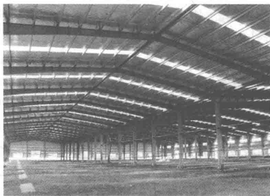
图 1-3 轻钢厂房门式刚架
