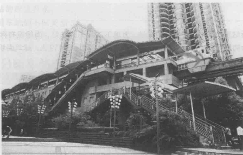
图 1.1.3 重庆轻轨高架车站
