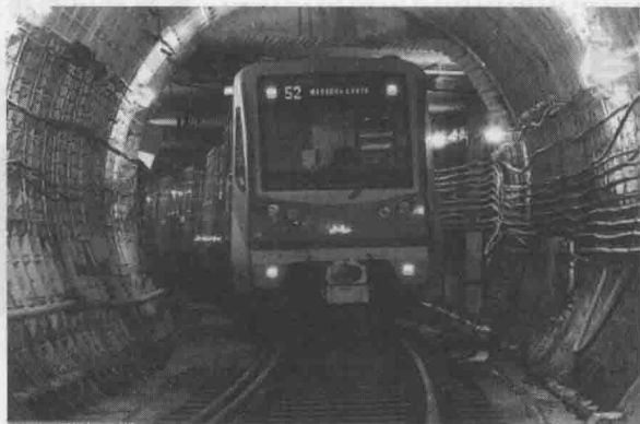
图 1.1.1 地铁区间隧道
