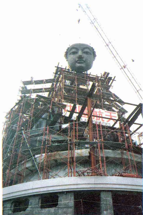
“佛臉”正在吊裝
