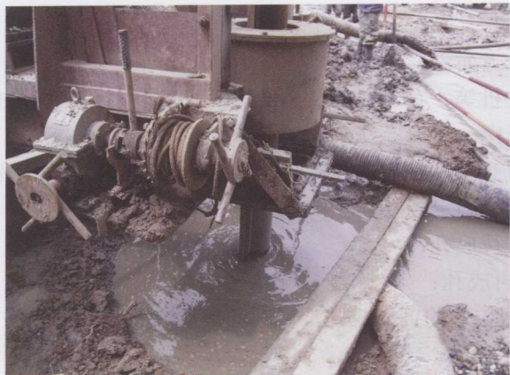
图 1-5-4 泥浆护壁成孔作业
