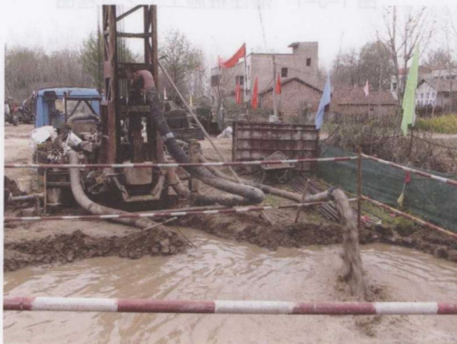
图1-4-1 灌注桩施工现场图
