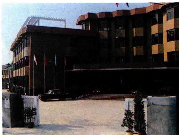
• 上海汽车厂办公大楼
